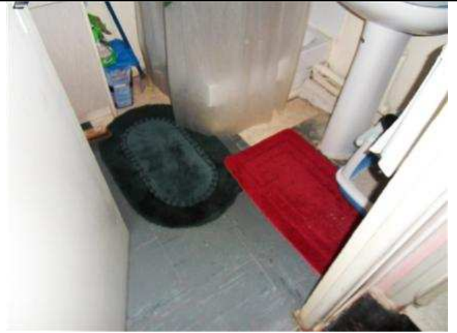
059 - Appartements - Salle d'eau LOT 0402 PH24 : dalles supérieures non amiantées Posées sur dalles, colle et ragréage amianté PRE024
